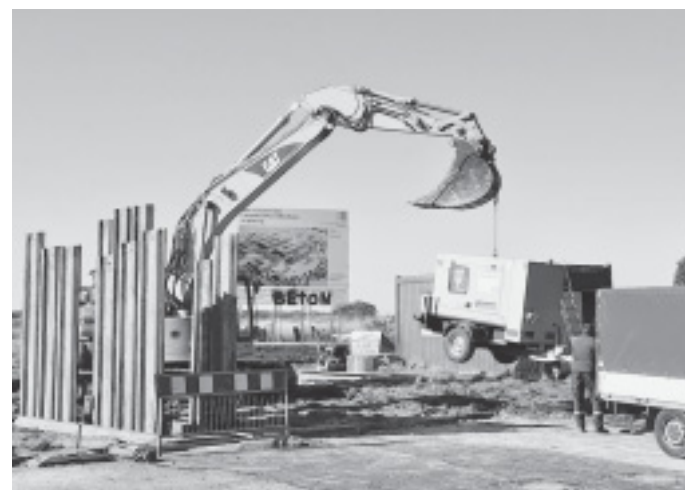
Es geht los: Auf der Langen Lage sind die ersten Erdhaufen verschoben worden. Hier soll der Hochschulcampus Bielefeld entstehen.
